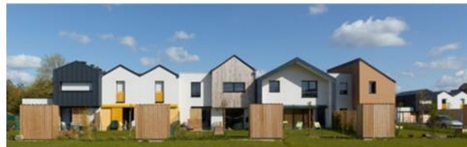
Opération groupée « Vert Buisson » à Bruz (35)
