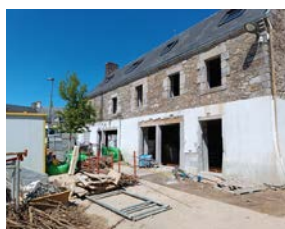
Réhabilitation de la boucherie
