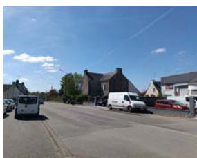
Enfouissement des réseaux route de Vannes
